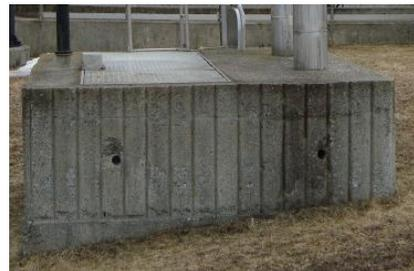
Cette problématique est malheureusement rencontrée dans de nombreuses stations de pompage d'eaux usées au Québec. Pour protéger les travailleurs contre une chute, il est alors nécessaire de donner un accès sécuritaire autour des trappes en rehaussant le terrain tout autour de la structure et en installant des garde-corps fixes ou amovibles autour des trappes d'accès.
