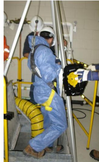
Il est alors très important de s'assurer de la compatibilité de la potence avec le socle ainsi que de celle de la potence avec l'adaptateur du dispositif auto-rétractable de type « enrouleur-dérouleur 3 fonctions » (antichute, ligne de vie et récupération d'urgence), sans quoi ceux-ci ne seront pas conformes aux normes et ne seront peut-être pas sécuritaires. En effet, tous les modèles et toutes les marques ne sont pas toujours compatibles entre eux.
