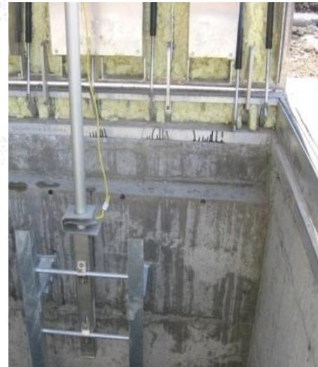
L'échelle doit dépasser de 900 mm
