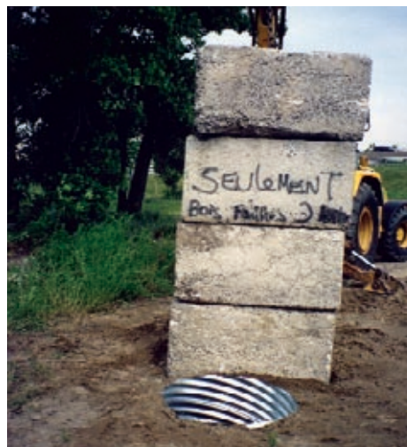
Figure 5 – Surcharge avec quatre blocs de béton
