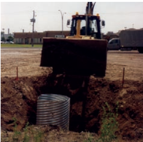
Figure 2 – Remblayage de la tranchée avec du sable
