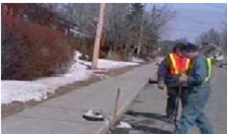
Levée d'une grille à rainures horizontales avec un protol
