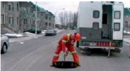
Levée d'un tampon à pattes avec un pic
