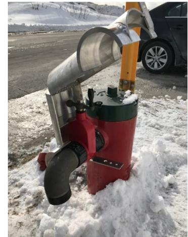
Dispositif de cadenassage pour le robinet à guillotine
