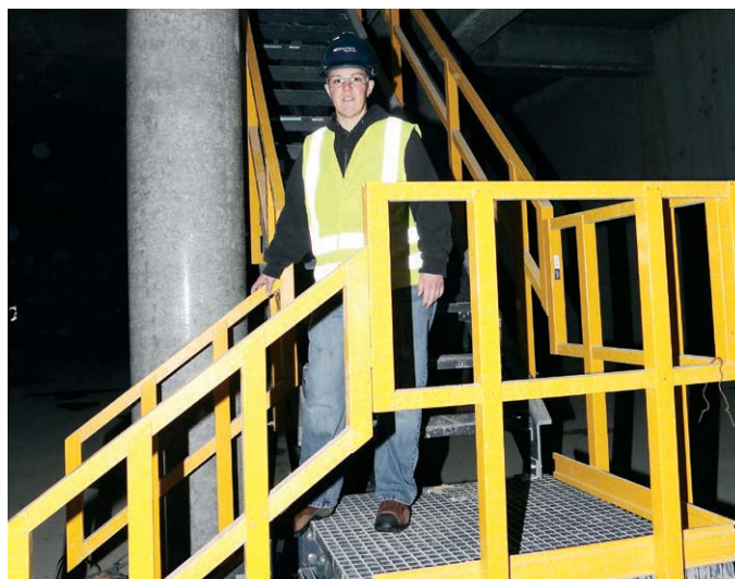
Travailleur s'apprêtant à descendre dans la réserve en empruntant l'escalier d'accès.
