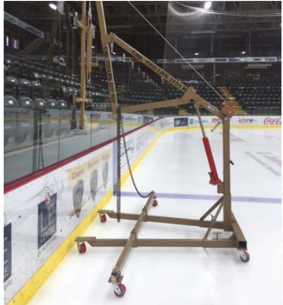
La nouvelle procédure permet le changement sécuritaire des baies vitrées
