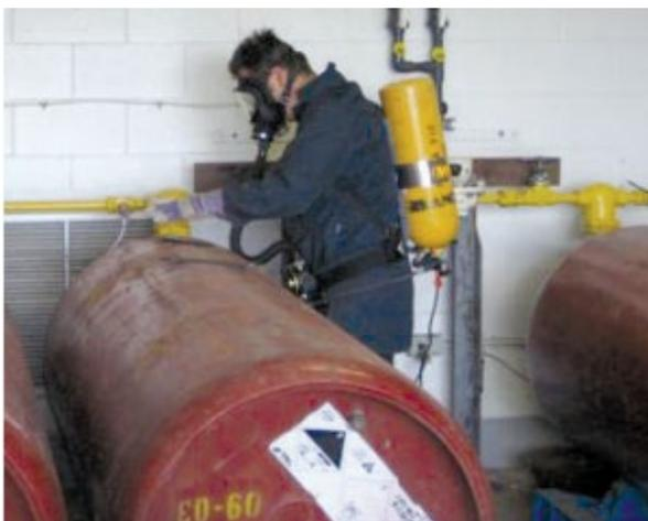
Port d'un APRIA pour le changement des bouteilles/cylindres de chlore gazeux
