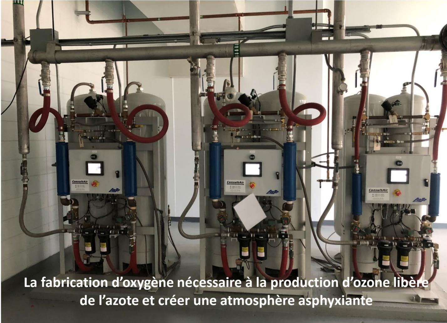
La fabrication d'oxygène nécessaire à la production d'ozone libère de l'azote et crée une atmosphère asphyxiante
