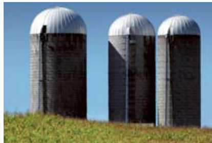
Silos / à grains, hermétiques / à fourrage
